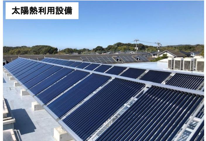
再生可能エネルギーの一つである“太陽熱利用”は、太陽から降り注がれる熱エネルギーを有効利用した地球環境に影響を及ぼさない環境にやさしいエネルギーです。自然界に存在する太陽の熱エネルギーを有効活用することで、日々の給湯で利用する石油やガスなどの化石燃料使用量を削減させることができ、温室効果ガスの排出抑制につながります。今回の太陽熱利用設備導入により、年間 29.91t-CO<sub>2</sub>もの二酸化炭素排出削減が見込めます。
